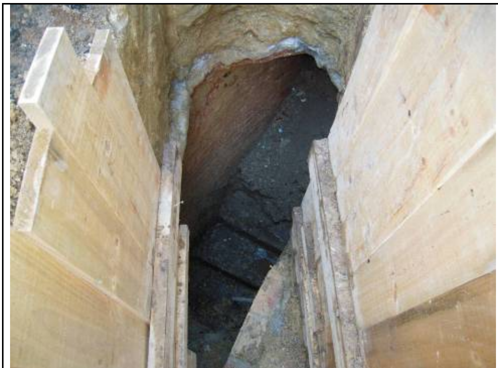
Foto 19: Vista general del tram netejat del refugi.
