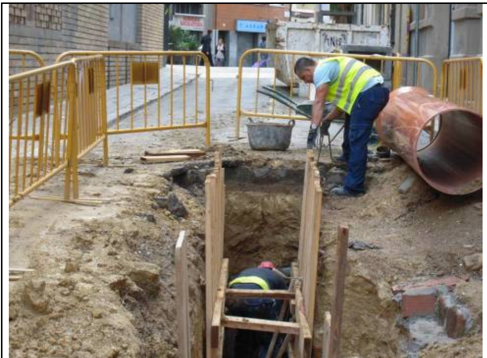
Foto 8: Treballs de neteja de l'interior de la galeria.
