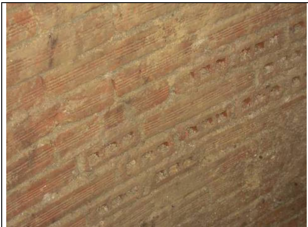
Foto 18: Detall dels totxos utilitzats per a la construcció del refugi.
