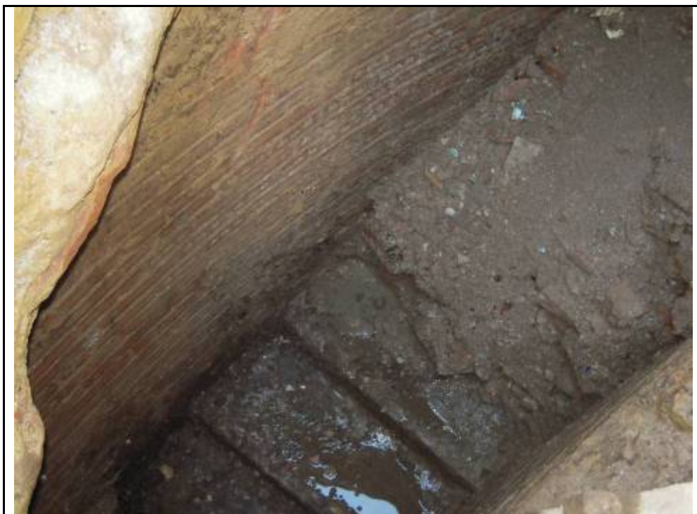
Foto 16: Acumulació de l'aigua als esglaons per les filtracions del terreny.
