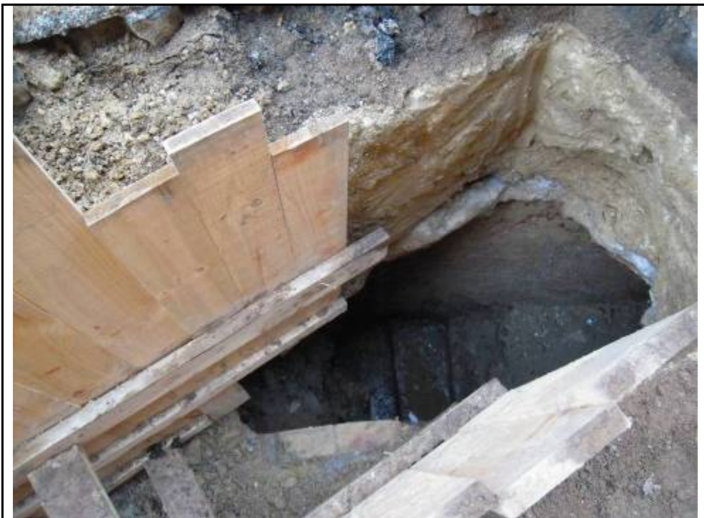
Foto 14: Imatge des del carrer actual amb els esglaons del refugi visibles.
