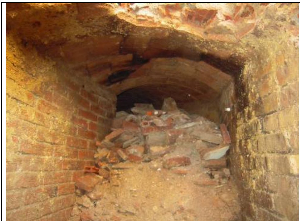
Foto 22: Vista de l'acumulació de la gran quantitat de runa existent.
