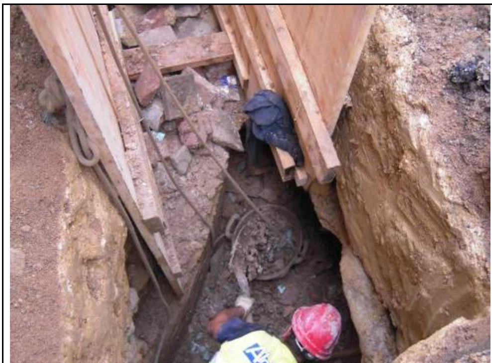
Foto 12: Imatge dels treballs de neteja del refugi.
