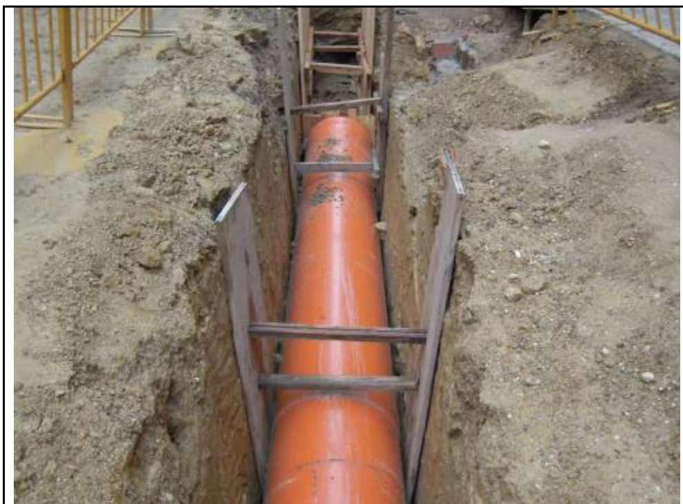
Foto 2: Detall del servei de clavegueram i la rasa construïda que afectà l'estructura defensiva.
