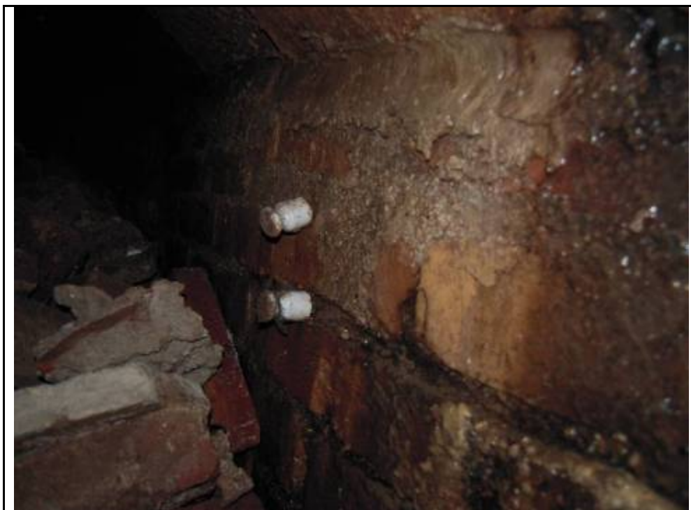
Foto 6: Imatge de detall de les resistències, que ens aporta informació de la il·luminació a l'interior del refugi antiaeri.
