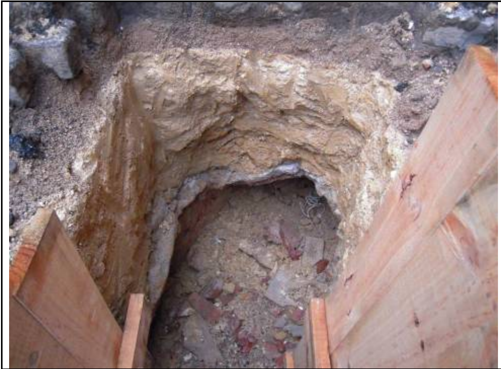
Foto 3: Imatge que mostra el trencament de la volta i l'aparició de la runa a l'interior del refugi.
