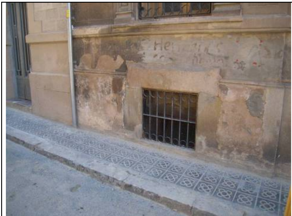
Foto 25: Punt exacte des d'on s'inicià el refugi a l'interior de la finca núm. 22 del carrer de Fernández Duró.
