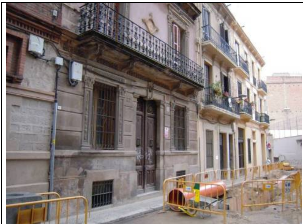
Foto 1: Vista general de l'estat inicial de l'obra constructiva al carrer de Fernández Duró. En primer terme, la finca núm. 22.
