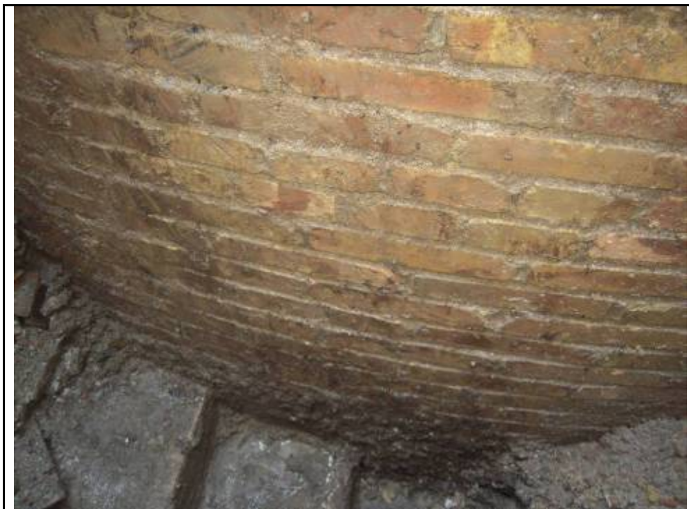
Foto 23: Detall dels esglaons de ciment i els totxos a les parets construïdes.
