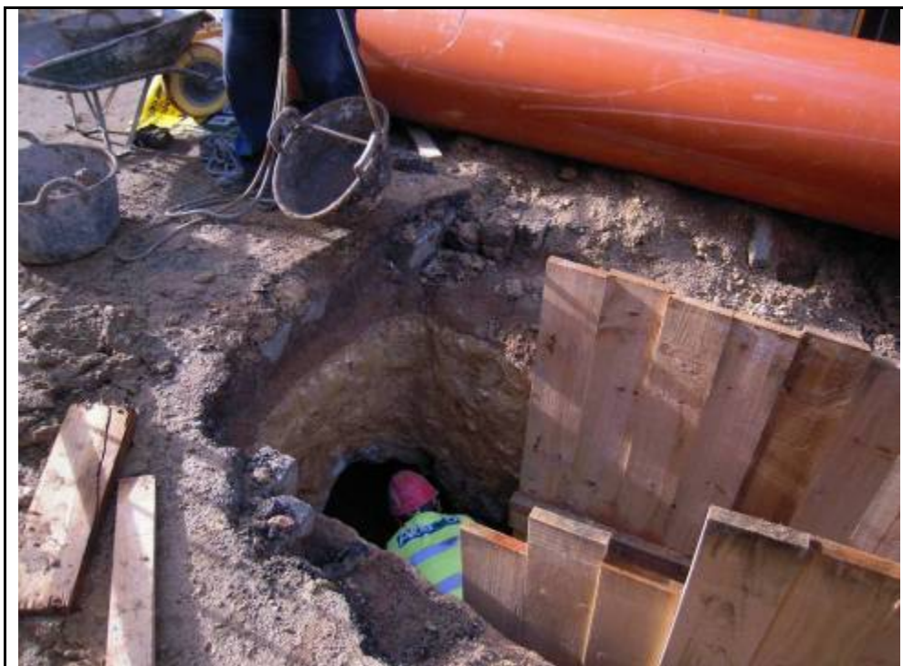
Foto 10: Detall dels treballs durant la neteja de la part de segment localitzat del refugi núm. 547.
