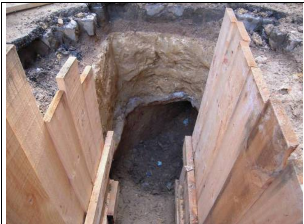
Foto 9: Detall de l'interior del refugi des de la rasa construïda per al clavegueram.
